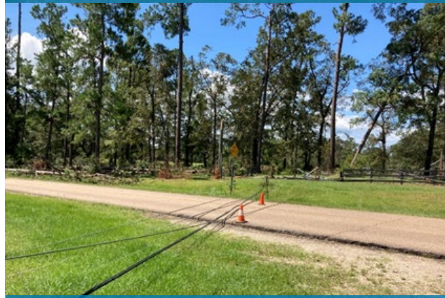
No conduzca sobre cables caídos.
